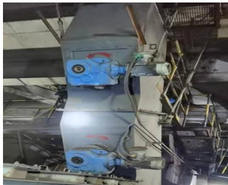
图7 皮带落煤管迎煤面增加清堵机
