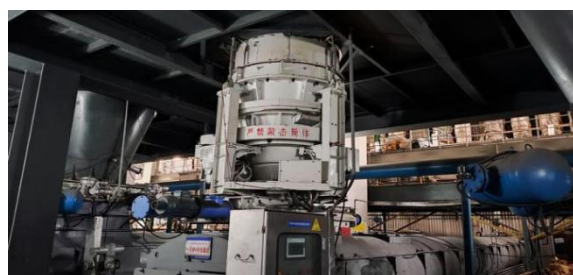
图 4 煤仓底部出口增加旋转清堵机
