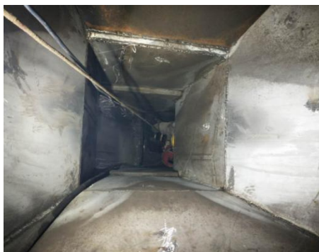
图6 皮带落煤管增加不锈钢板
